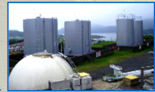
油50klタンク設置
