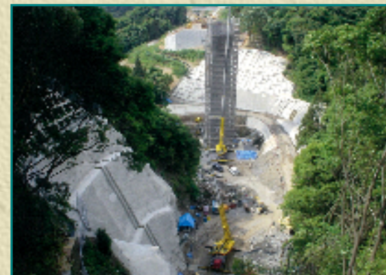
一般国道206号橋梁整備工事
