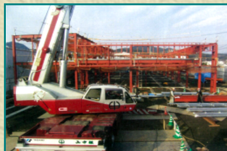
某銀行某支店新築工事
