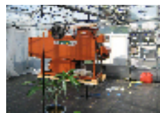
重油焚き加温機＋空冷ヒートポンプ
