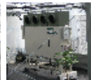
重油焚き加温機＋空冷ヒートポンプ
