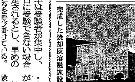
完成した焼却灰溶融施設
